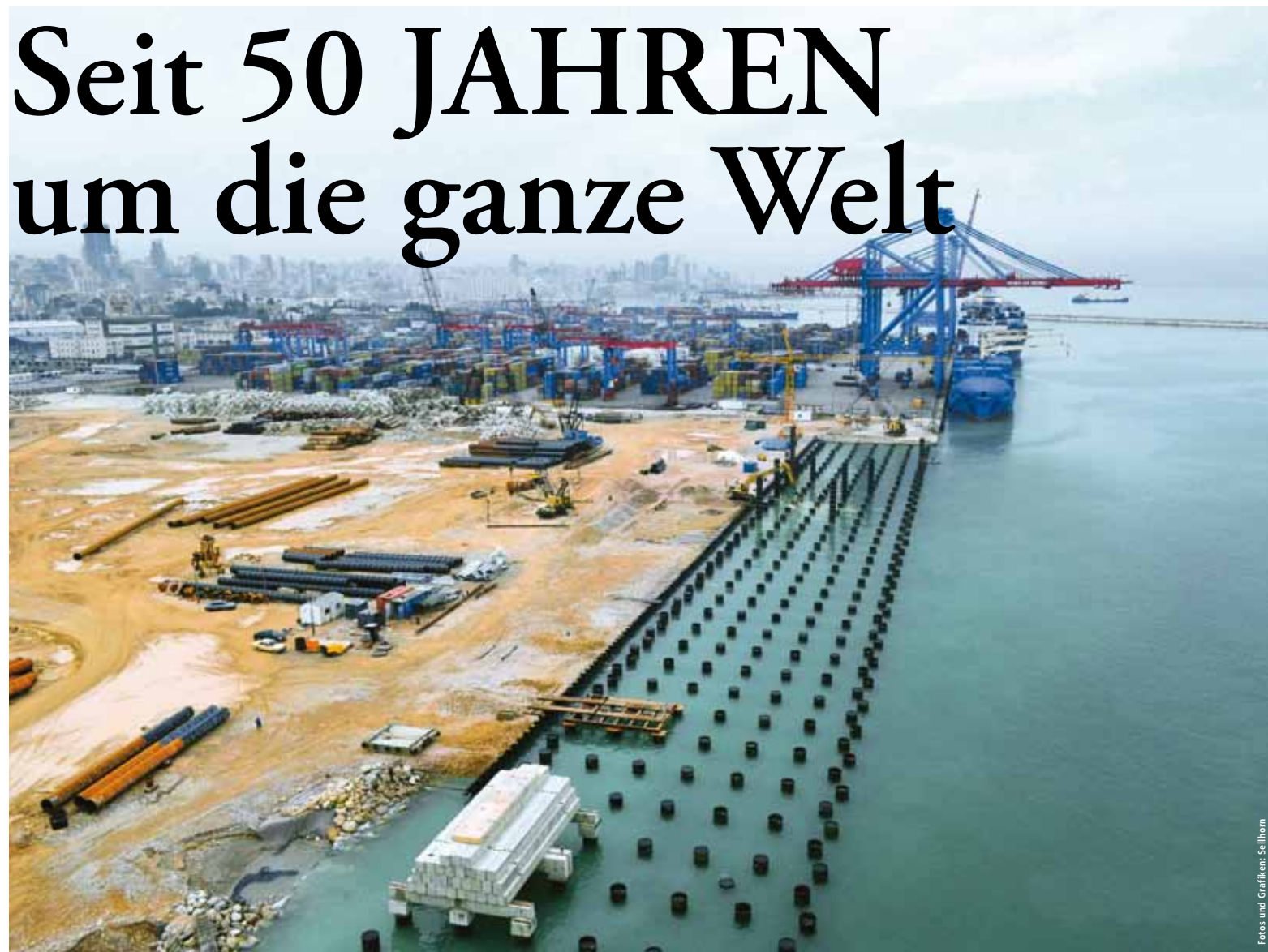
Heute: Baufeld der Terminalerweiterung im Hafen Beirut im Dezember 2011
