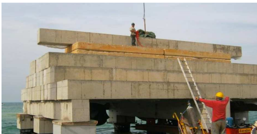
Durchführung statischer Pfahlbelastungstest
