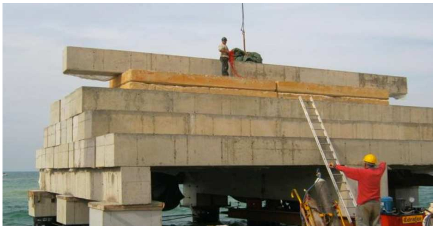
Durchführung statischer Pfahlbelastungstest
