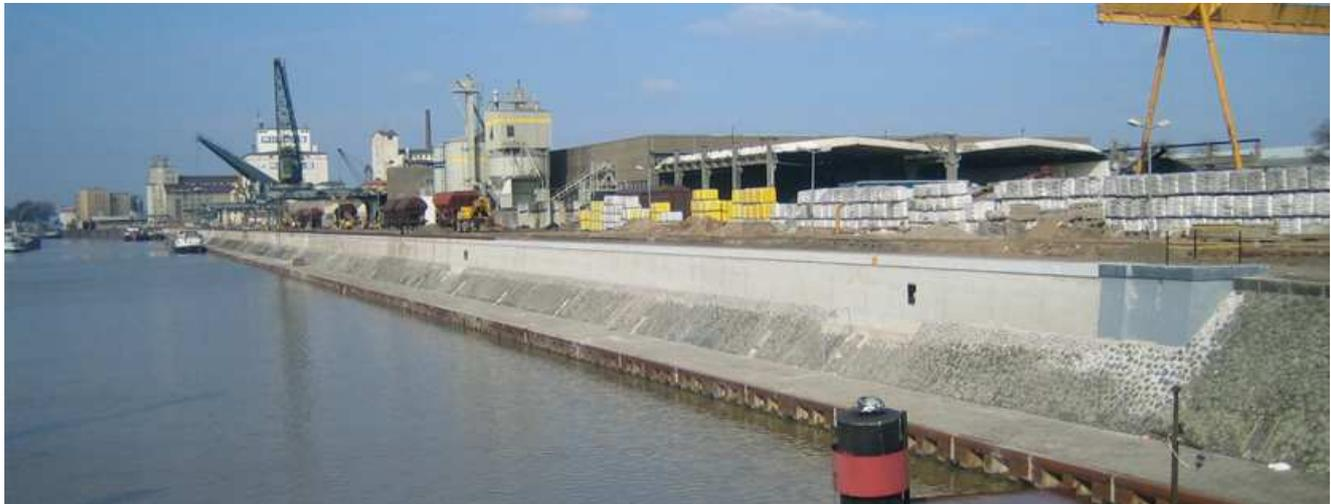
Der Mainhafen in Hanau nahm im Jahre 1924 den Betrieb auf. Die Uferbefestigungen stammen aus dieser Zeit. Eine betontechnologische Untersuchung und eine gutachterliche Stellungnahme kamen zu dem Schluss, dass der Kranbahnholm der Kaimauerkonstruktion nicht mehr standsicher war und saniert werden musste.
