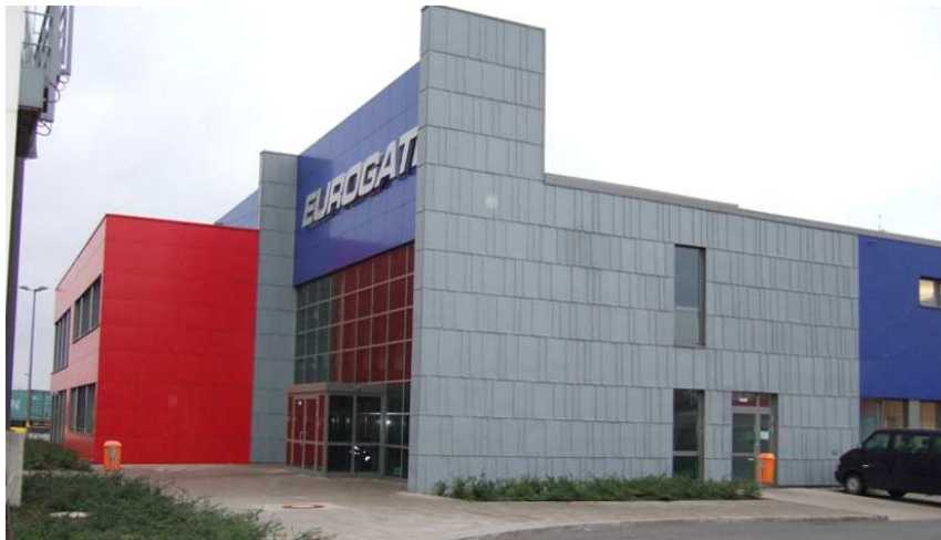
Südostansicht bestehendes Gebäude 13, Trakt 1 und 2
