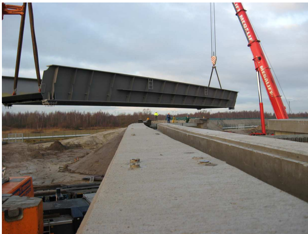
Einheben des Überbaus der Eisenbahnbrücke über die Straße Am Tiefen Fahrwasser
