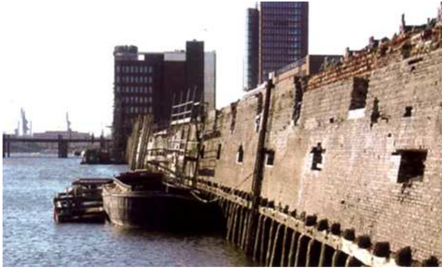
Kaimauer am Sandtorkai vor der Sanierung
