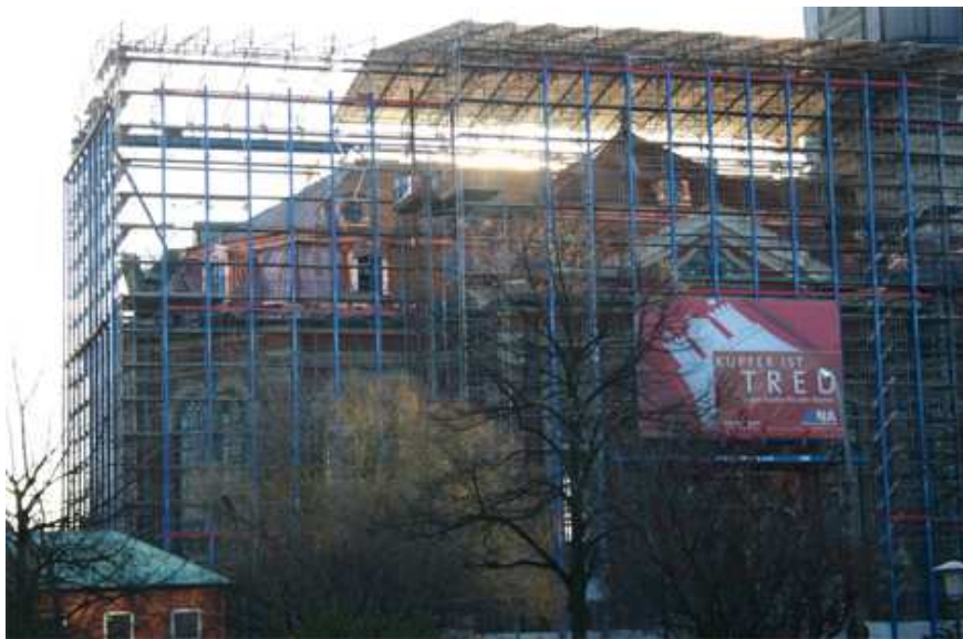
Einrüstung des Kirchenschiffes zur Dachsanierung 2008
