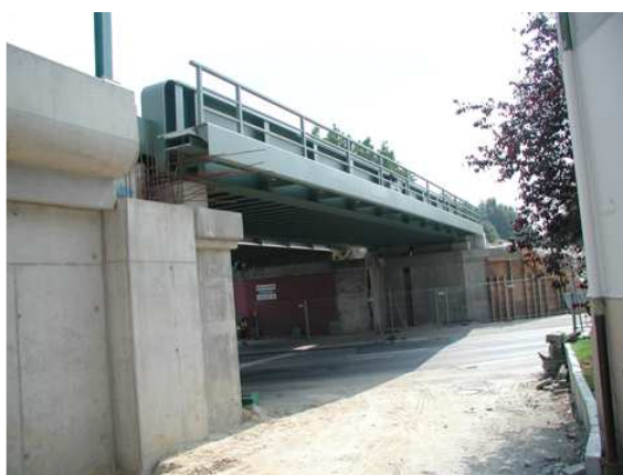
Stahlbrücke im Anschluss an die Winkelstützwand
