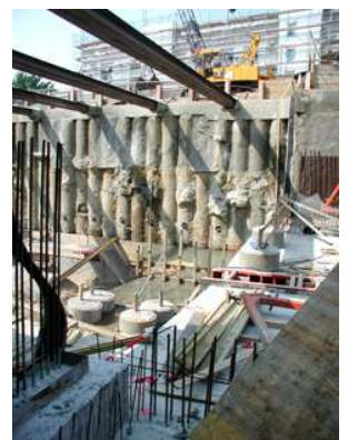
Herstellung des Regenwasserrückhaltebeckens
