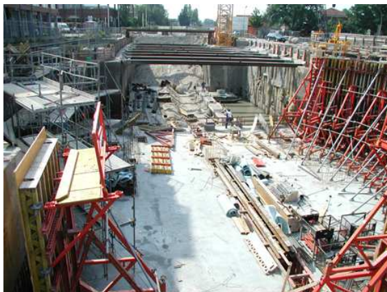
Bau der südlichen Zugangsanlage mit Blick nach Süden
