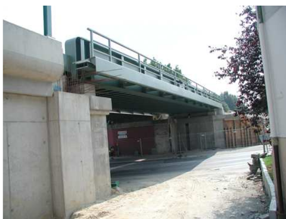
Stahlbrücke im Anschluss an die Winkelstützwand
