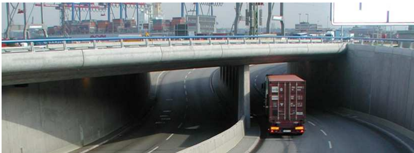
Südportal des Bauwerks
