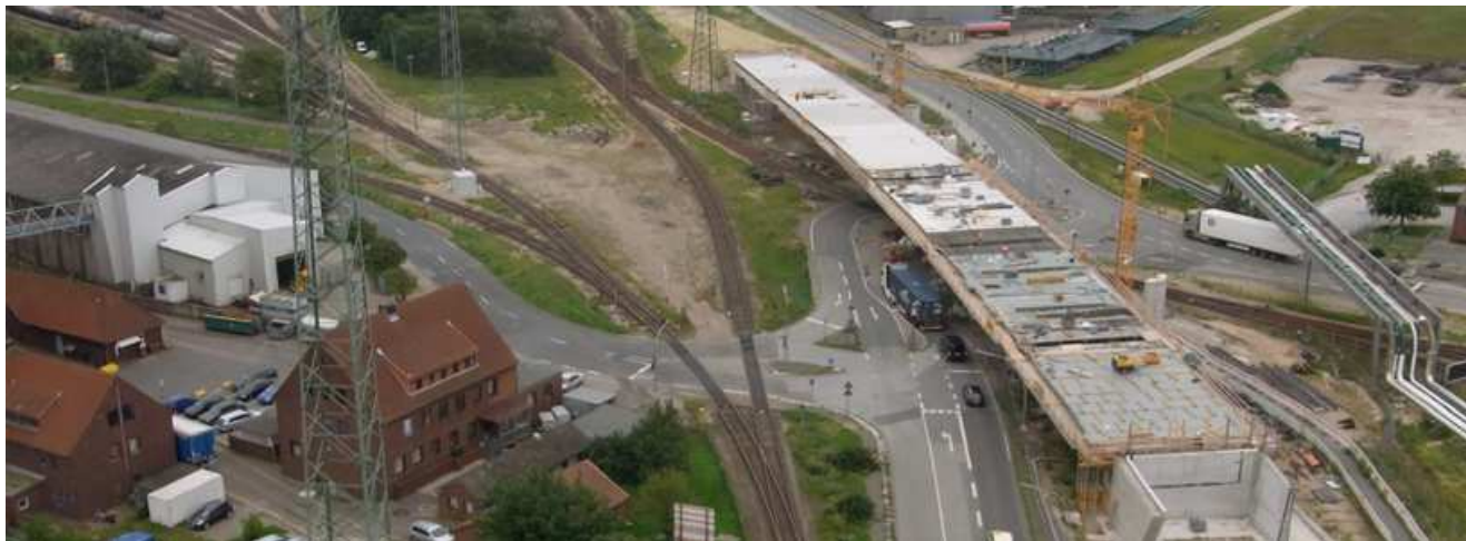
Übersicht der Baumaßnahme Straßenüberführung Hohe-Schaar-Straße
