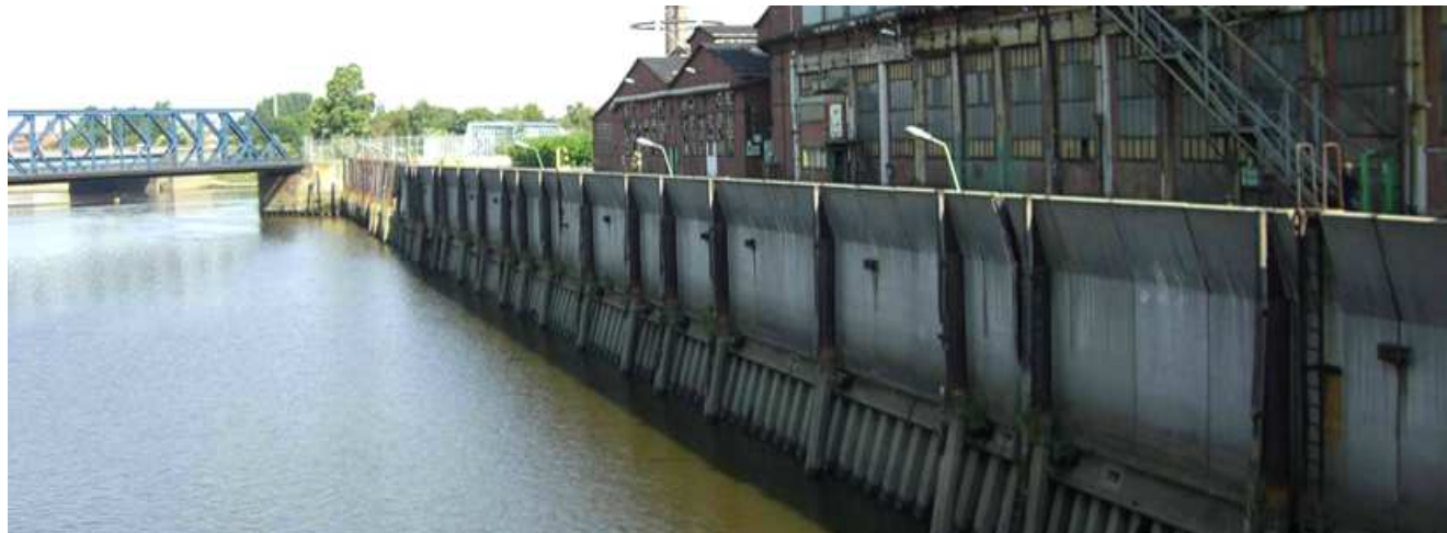
Kaimauerbestand – Blöcke Va, Vb und V
