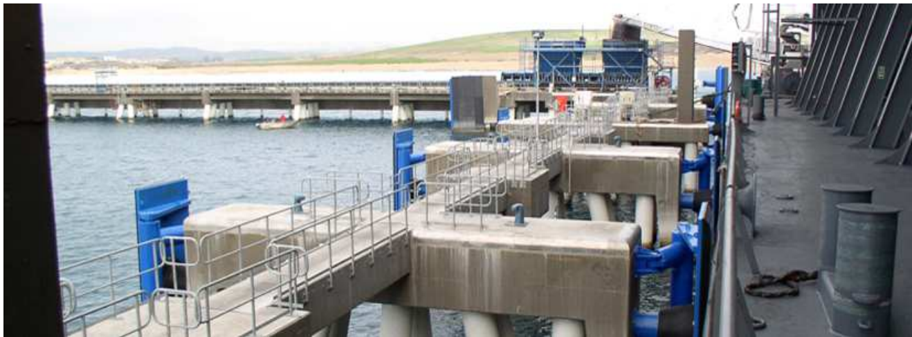
Zugangsbrücke und Anleger, Iskenderun
