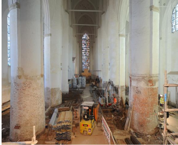
Baustelle Kirchenschiff: Komplette Erneuerung des Bodenaufbaus, © Michael Zapf
