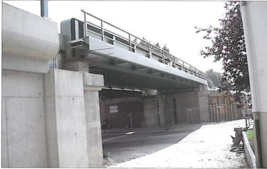
Bild 5: Stahlbrücke für das zweite Gleis über die Elbgaustraße mit Anschluss an die Winkelstützwand zur Planumsverbreiterung (Quelle: Sellhorn - ICB)
