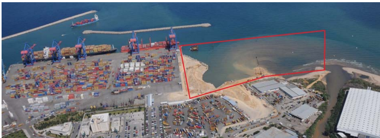
Bild 1: Zustand zu Beginn der Bauarbeiten, März 2010, rechts mit neuer Terminalfläche
