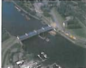
Sperrwerk Billwerder Bucht
