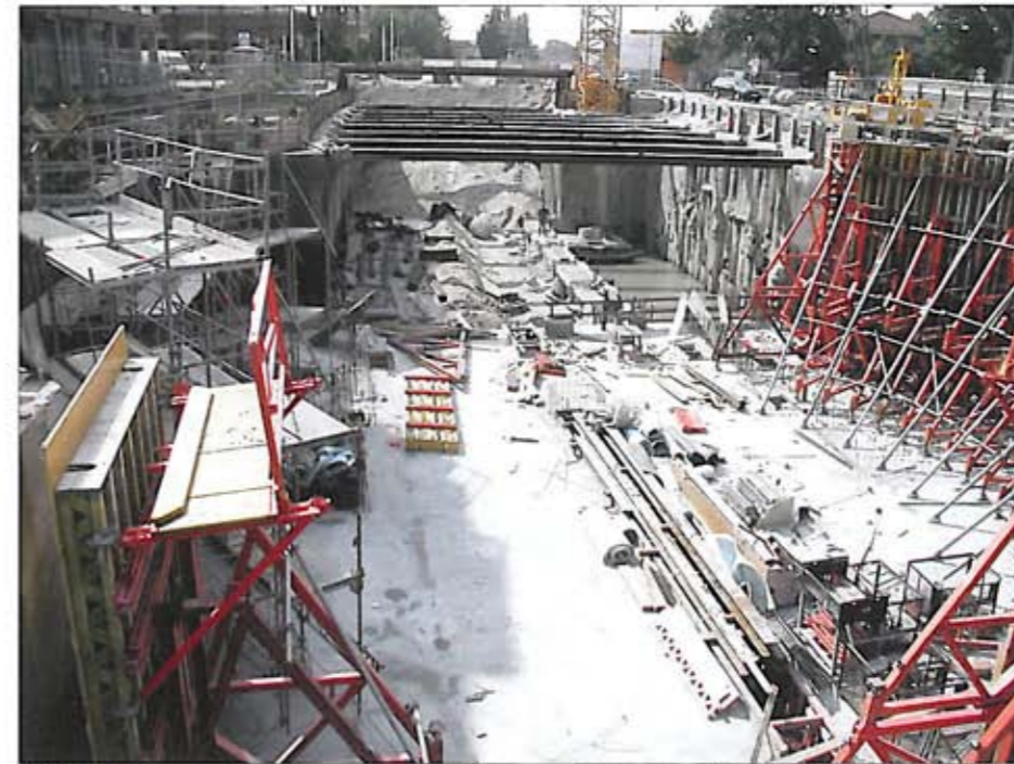
Bild 7: Trogbauwerk im Bauzustand. Im Hintergrund Streckenabschnitt Eidelstedt Ost-Eidelstedt. Im Vordergrund die kreisförmige Aufweitung des Trogs für die südliche Zugangsanlage Eidelstedt Zentrum (Quelle: Sellhorn - ICB)
