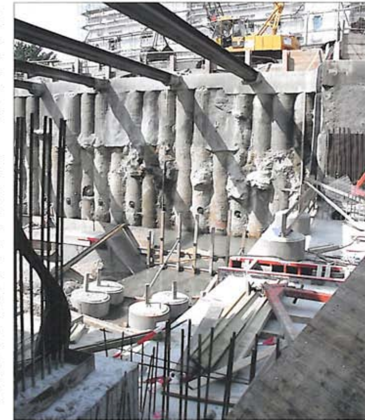
Bild 7: Trogbauwerk im Bauzustand. Im Hintergrund Streckenabschnitt Eidelstedt Ost-Eidelstedt. Im Vordergrund die kreisförmige Aufweitung des Trogs für die südliche Zugangsanlage Eidelstedt Zentrum (Quelle: Sellhorn - ICB)
