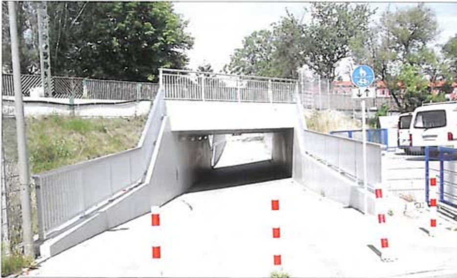
Bild 6: Fuß- und Radweg-Unterführung Niekampsweg (Quelle: Sellhorn - ICB)
