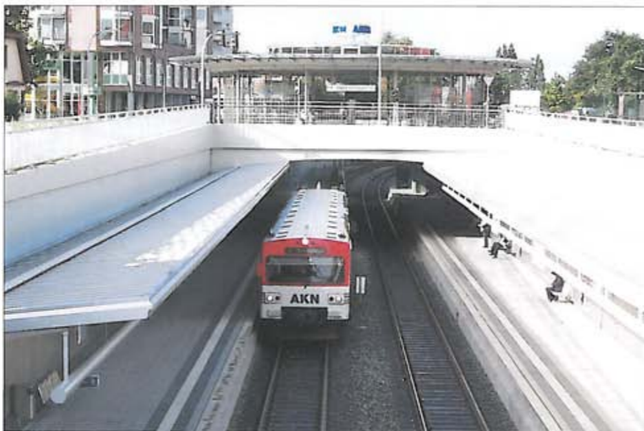
Bild 1: Der neue AKN-Haltepunkt Eidelstedt Zentrum – Kernstück der Ausbaustrecke von Eidelstedt bis Schnelsen (Quelle: AKN)
