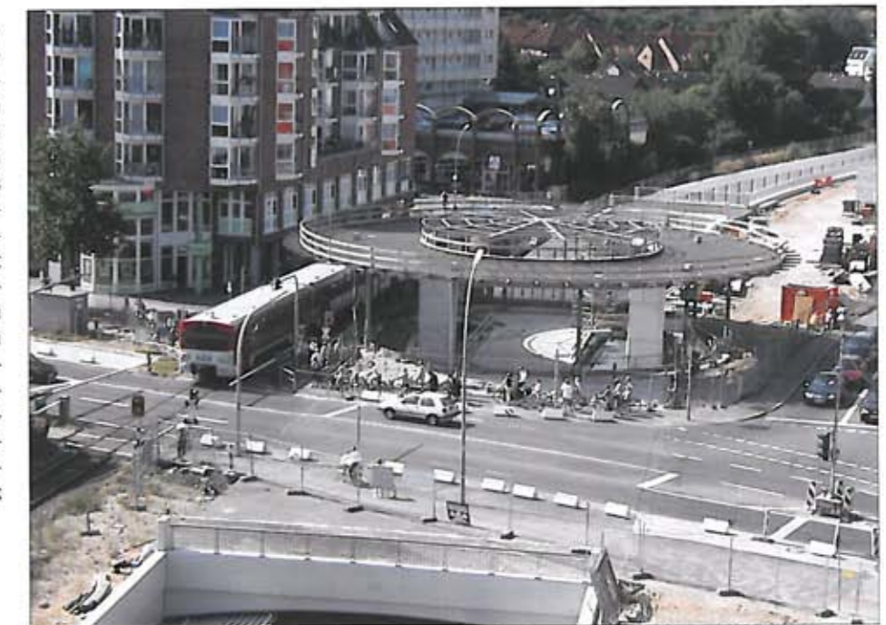
Bild 10: Beispiel für Bauzustände zur Tieferlegung der AKN-Trasse mit Zweigleisigkeit: AKN-Triebwagen auf alter Trasse neben dem Trogbauwerk und der Rotunde für den Bahnhof Eidelstedt Zentrum
