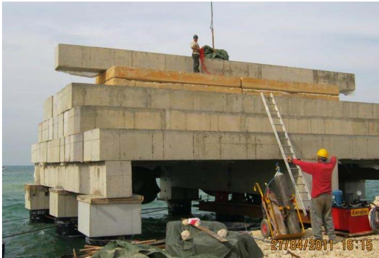
Bild 7: Durchführung statischer Pfahlbelastungstest
